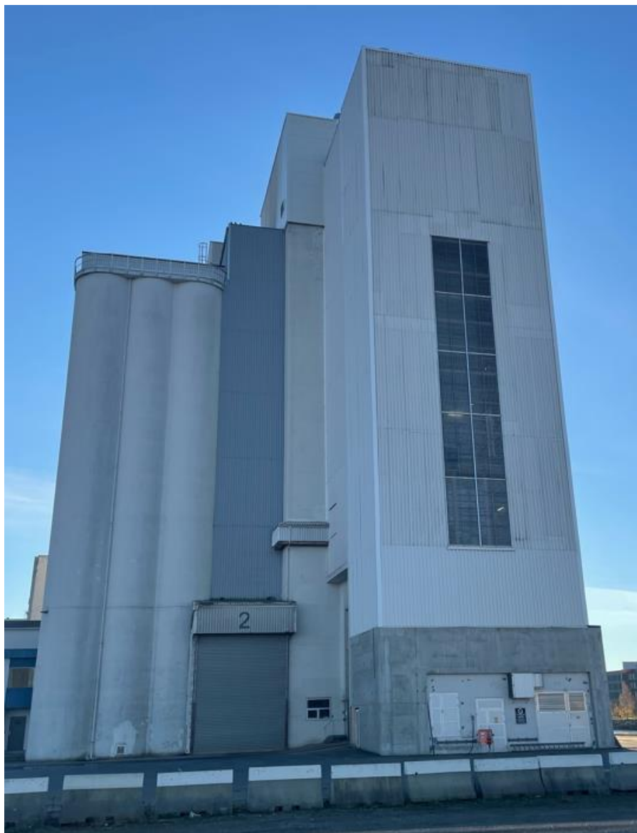
Bilde tatt 24.10.22 og viser det nye tørkebygget
