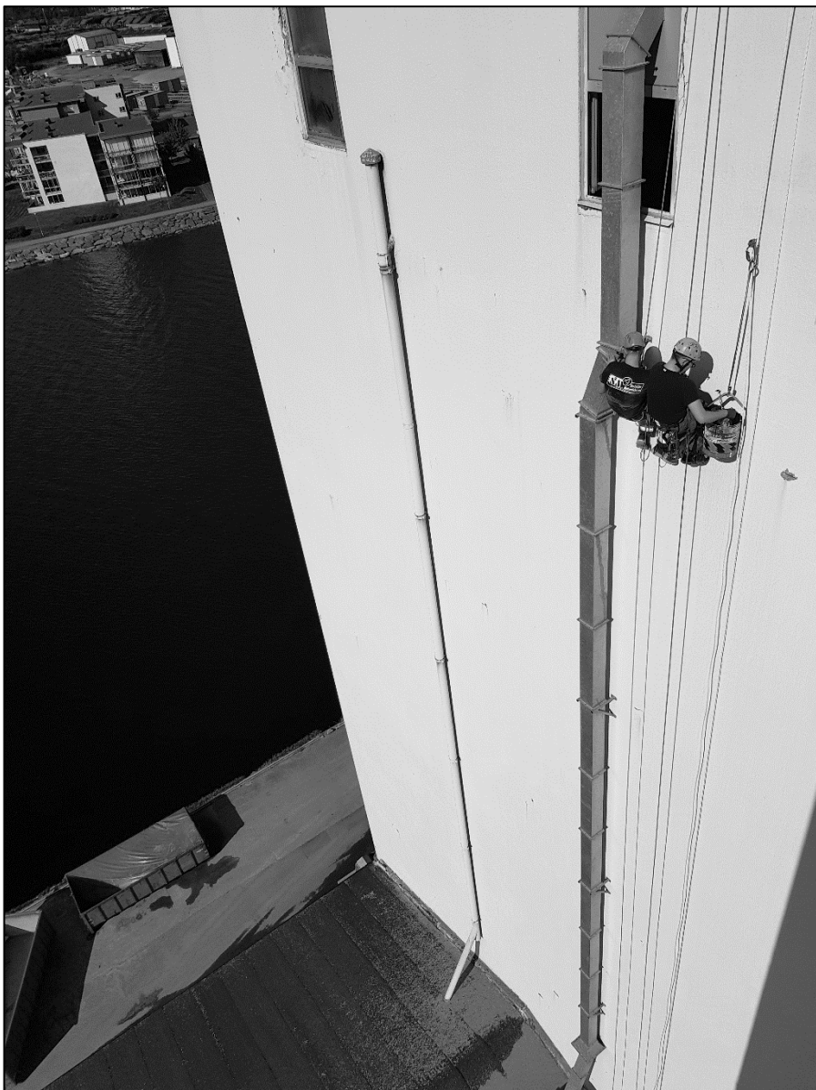
Steinkjer Mekaniske utfører reparasjon av kornrør på yttervegg.
